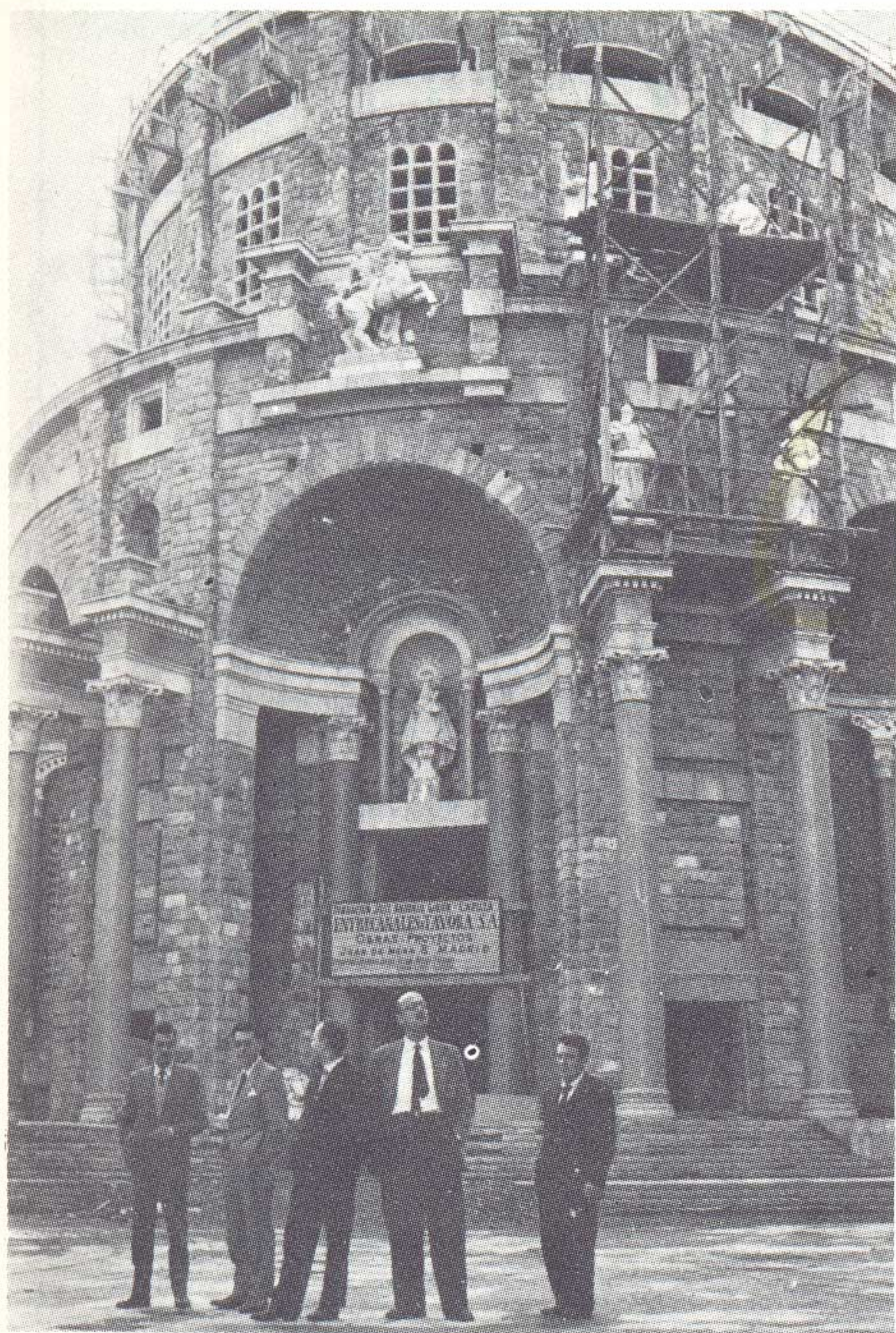
Arco de medio punto sobre el que se levanta la gigantesca torre de la Universidad Laboral de Gijón (en fase de construcción), la primera creada en España.
